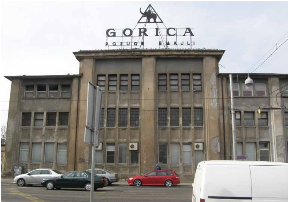
▲ PRIKAZ 10, PROIZVODNA ZGRADA TVORNICE PJENICE (DESTILERIJA)
