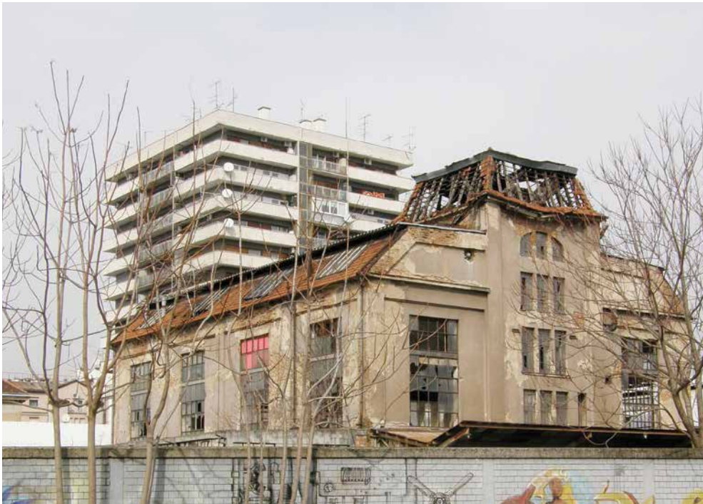
▲ PRIKAZ 11, ZGRADE RAFINERIJE I PECARE ŽESTE, KASNIJE DIO TVORNICE 'GORICA'
